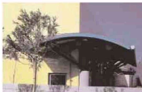
San Diego (USA), Metro Bisolidos Center, Metropolitan Wastewater Dept. Design Tucker, Sadler & Associates Dettaglio del rivestimento delle pareti eseguito con piastrelle in monocottura Ceramica Vogue
